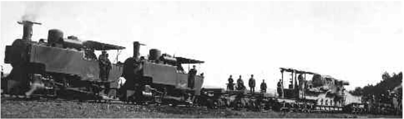
*Canon de 320 mm sur truck, remorqué par 4 locomotives sur voie Hanscotte aux Couillottes (1918)*
