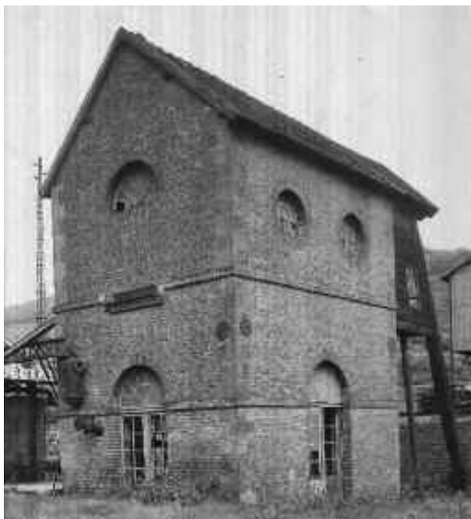
Bâtiment du puits d'exhaure XIII de la houillère du Creusot, au début des années 1920. Cet équipement est celui dont l'emploi a duré le plus longtemps à la mine du Creusot. Fonds AFB
