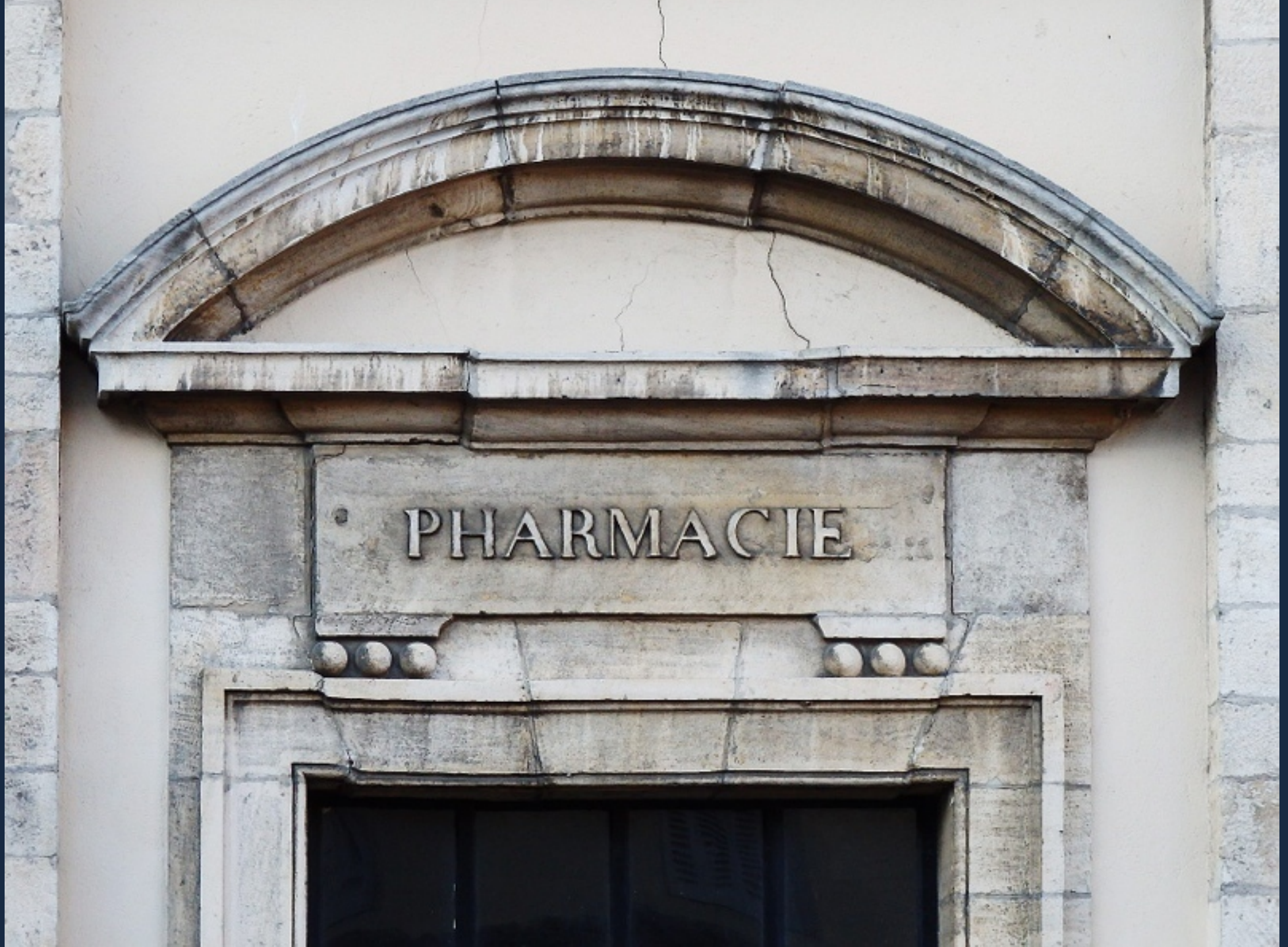
Pierre de taille : encadrement des ouvertures et avant-corps
