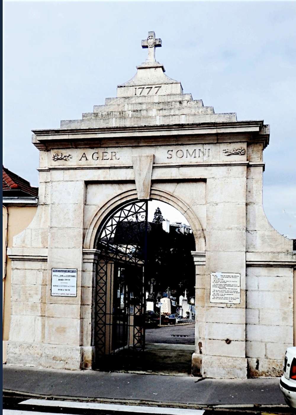
Grande porte d'entrée cimetière général du «Champ-Rollet» Devis clôture du voyer F. Chevreux, PV réception travaux Cl. Niépce (1779)
