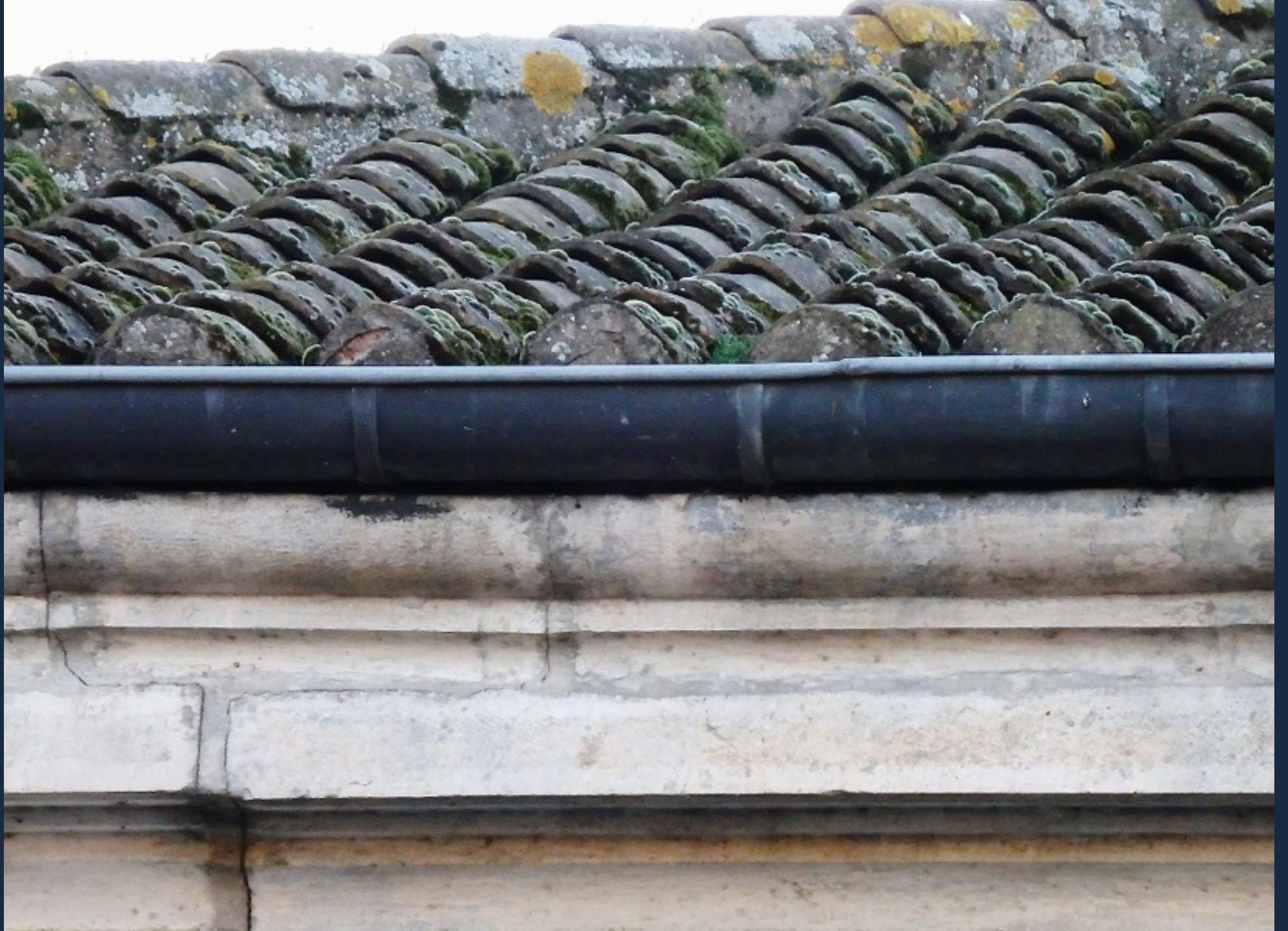
Couverture en tuiles romanes au niveau de la corniche
